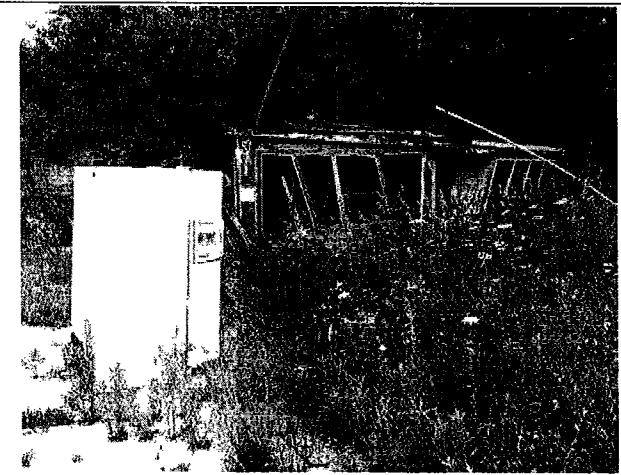
Photo 5) Sun Room/Pump Bldg. ~500 ft 2
